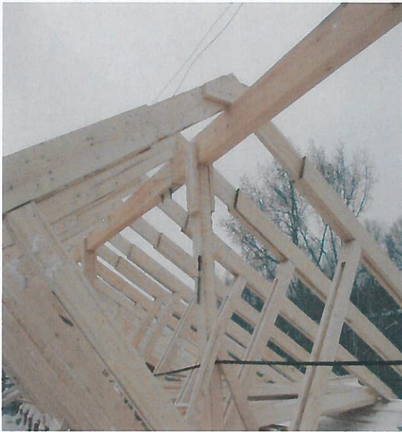
Проведение капитального ремонта крыши в многоквартирном доме по адресу: г. Томск, ул. Б. Куна д. 2
