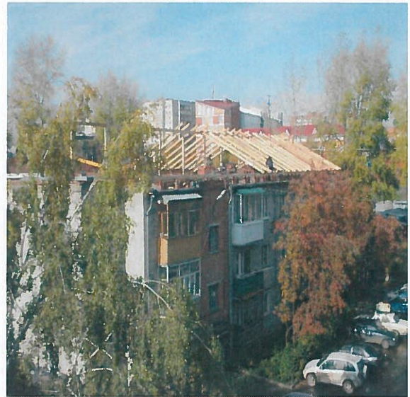
Ремонт крыши в многоквартирном доме по адресу: г. Томск, ул. Калужская, д. 17
