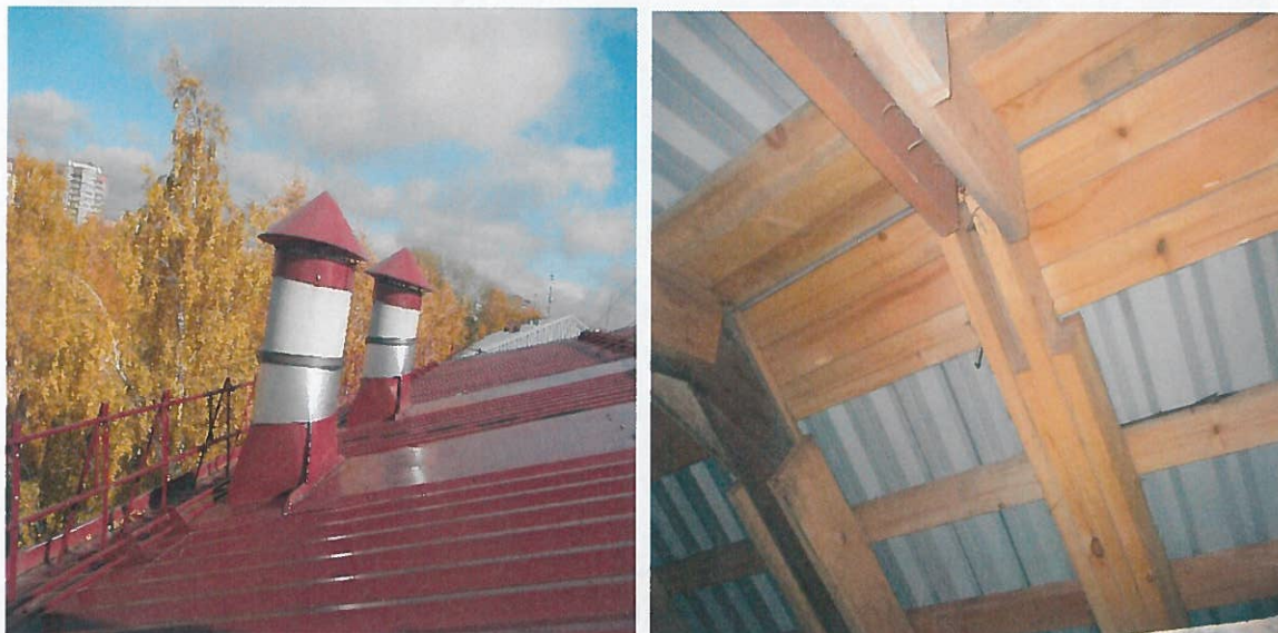
Крыша многоквартирного дома по адресу: г. Томск, Иркутский тракт, д. 80/1 после капитального ремонта
