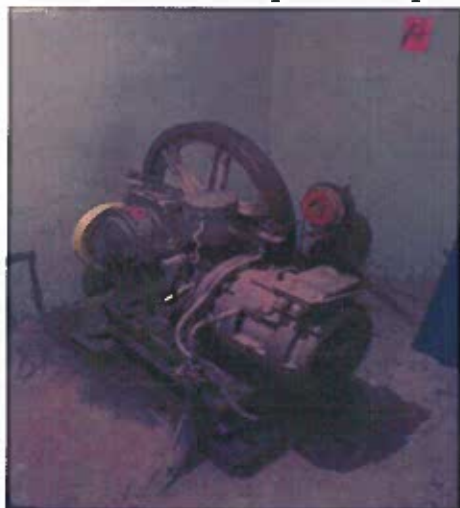
Лебедка в машинном отделении до и после ремонта лифтового оборудования
