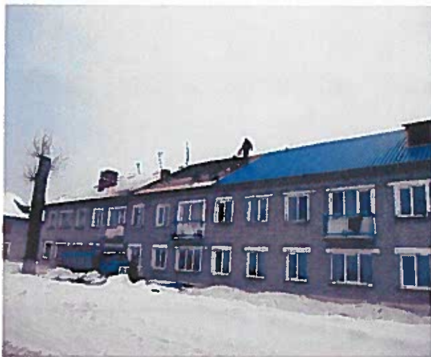
Многоквартирный дом в г. Асино по ул. 9 Мая, 62 включен в Краткосрочный план 2014 года. Ведутся работы по ремонту
